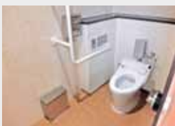
多機能トイレ(例)
