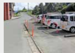
段差の解消(現状)
